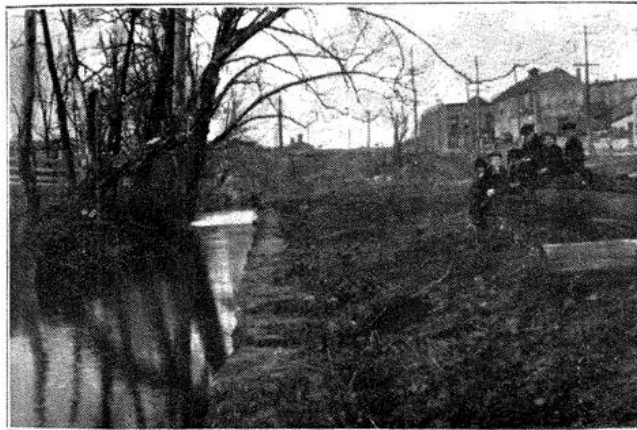
Showing Walls and Commons
